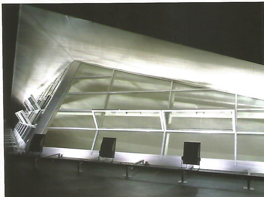
Venezianas no imóvel possibilitam a extração de fumaça em caso de incêndio
