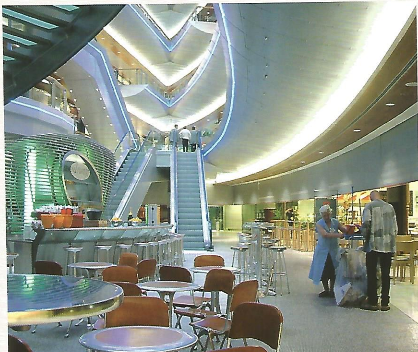
Shopping com cortina de acantonamento para conter a fumaça em caso de incêndio
